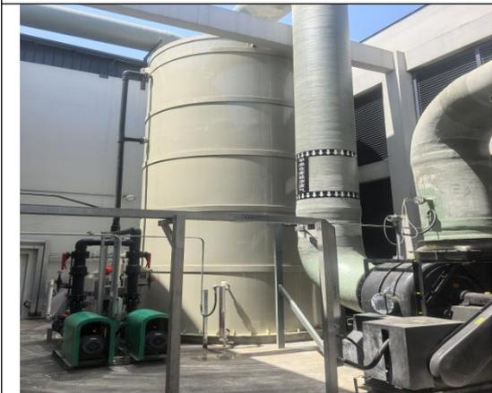
固废堆场废气喷淋塔
