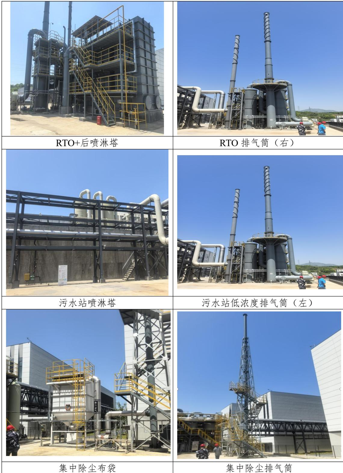
图 4-16 废气处理装置及排气筒
